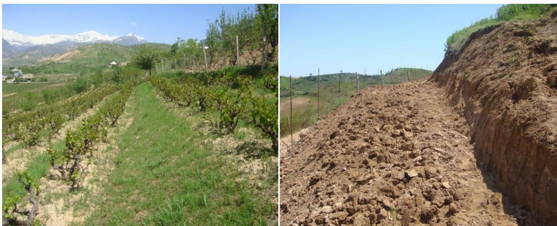
**Фото 6.1.3-Стадии образования канавы-террасы в бассейне реки Алмосы (узкополосчатое размещение ручным способом для виноградников**
